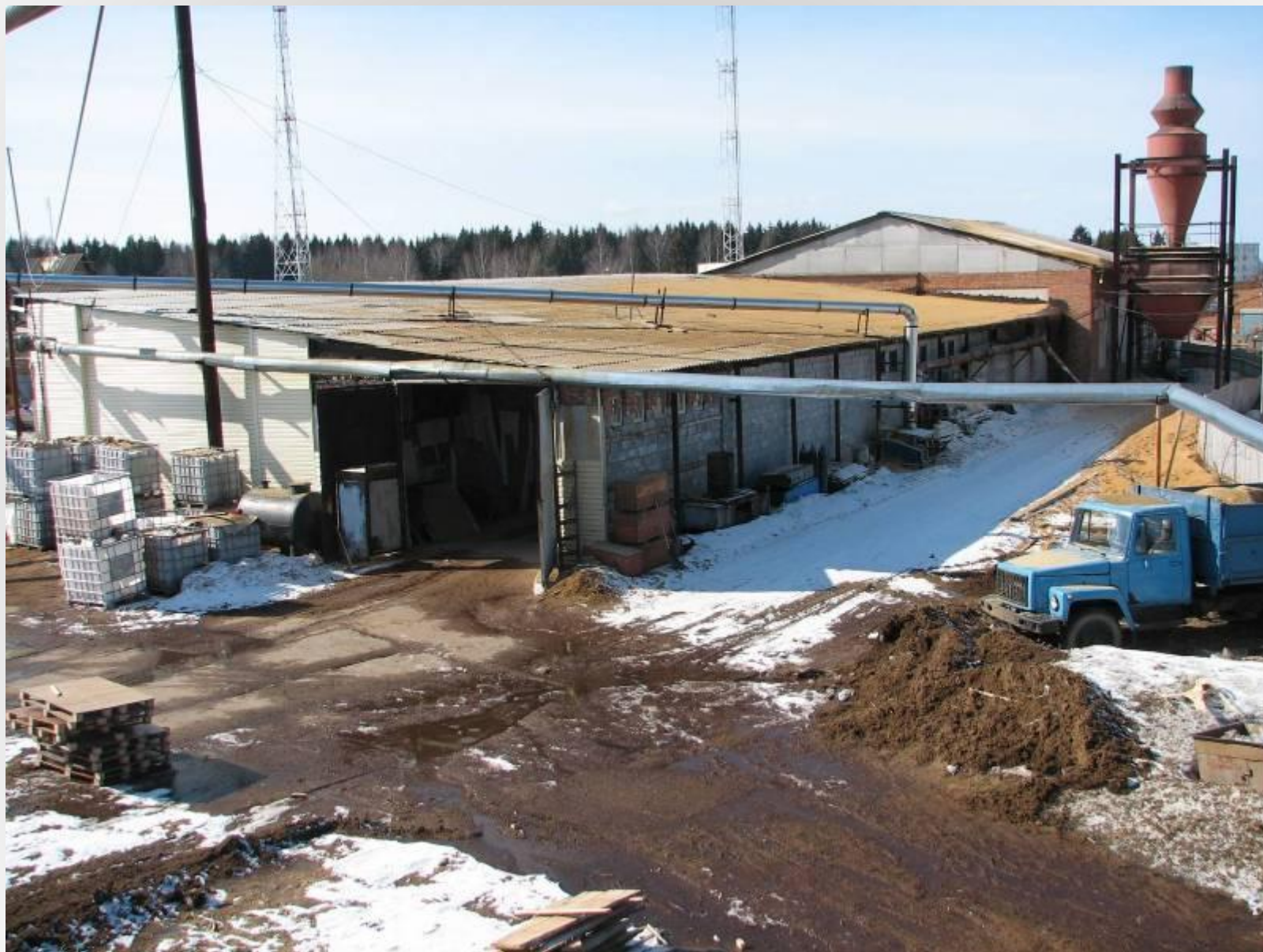
Вид на гараж (паркетный цех) со 2 этажа цеха паркетной доски
