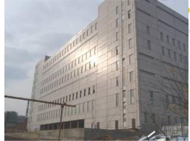
**Фасады:** Самонесущие, навесные ж/б панели. Заполнение оконных проемов, окна из пластикового профиля
