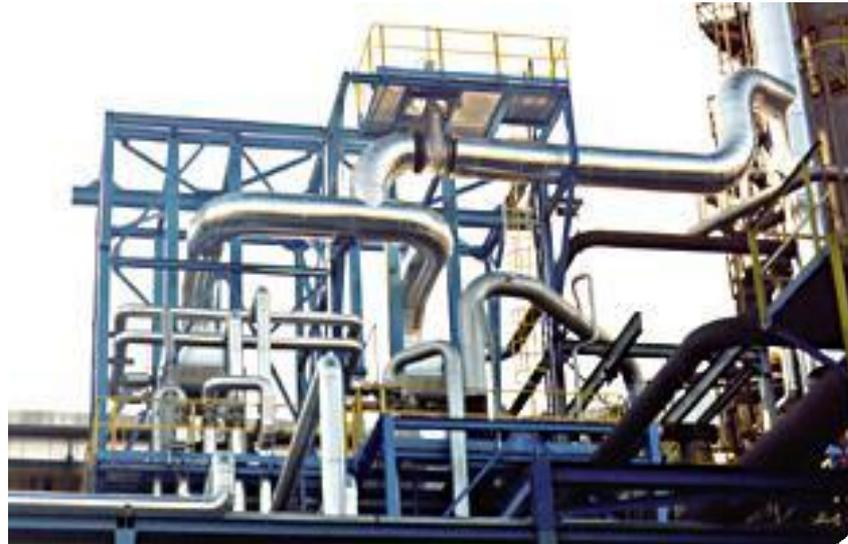
*Нефтеперерабатывающий завод Тамоила в Швейцарии преуспел в восстановлении большого количества тепла с помощью четырех теплообменников Comtrabloc для конденсации пара*
