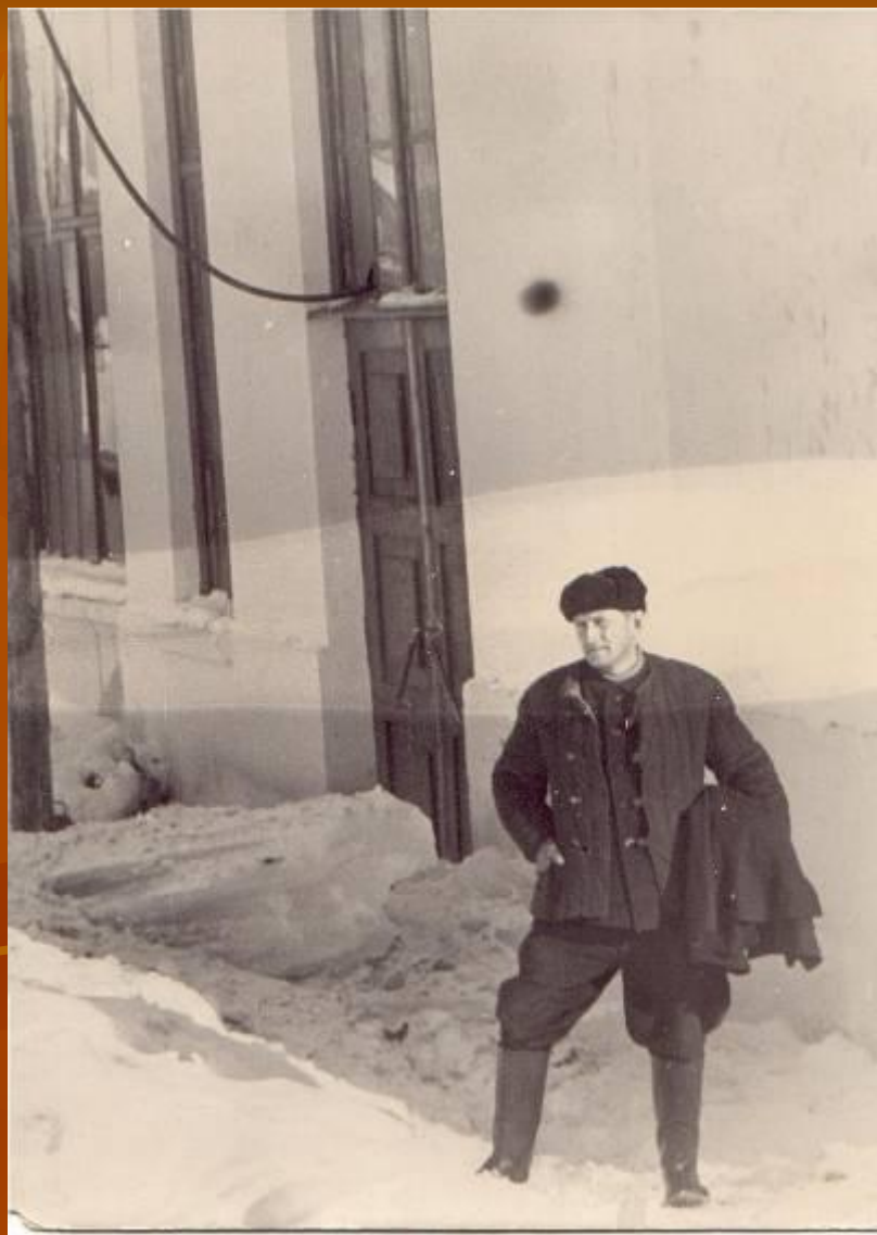
Оперативный выезд директора Лениногорского каскада ГЭС И.В. Бердуса на один из объектов в сложной производственной ситуации
