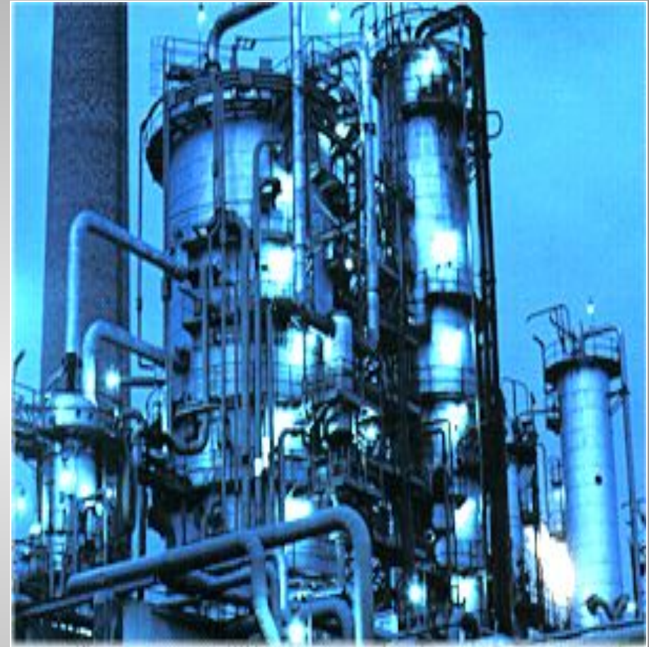
На нефтеперерабатывающих заводах из сырой нефти изготавливают до 500 000 видов различной продукции
