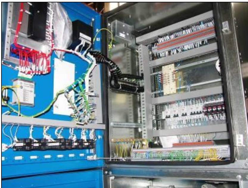
◀ Электрический монтаж релейного шкафа
