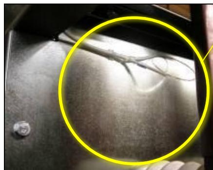
▶ Датчики в отсеке сборных шин
