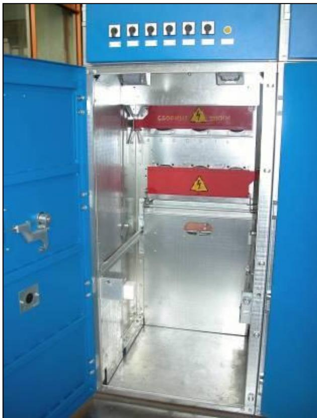
▲ Отсек выкатного элемента линейного шкафа серии K-129
