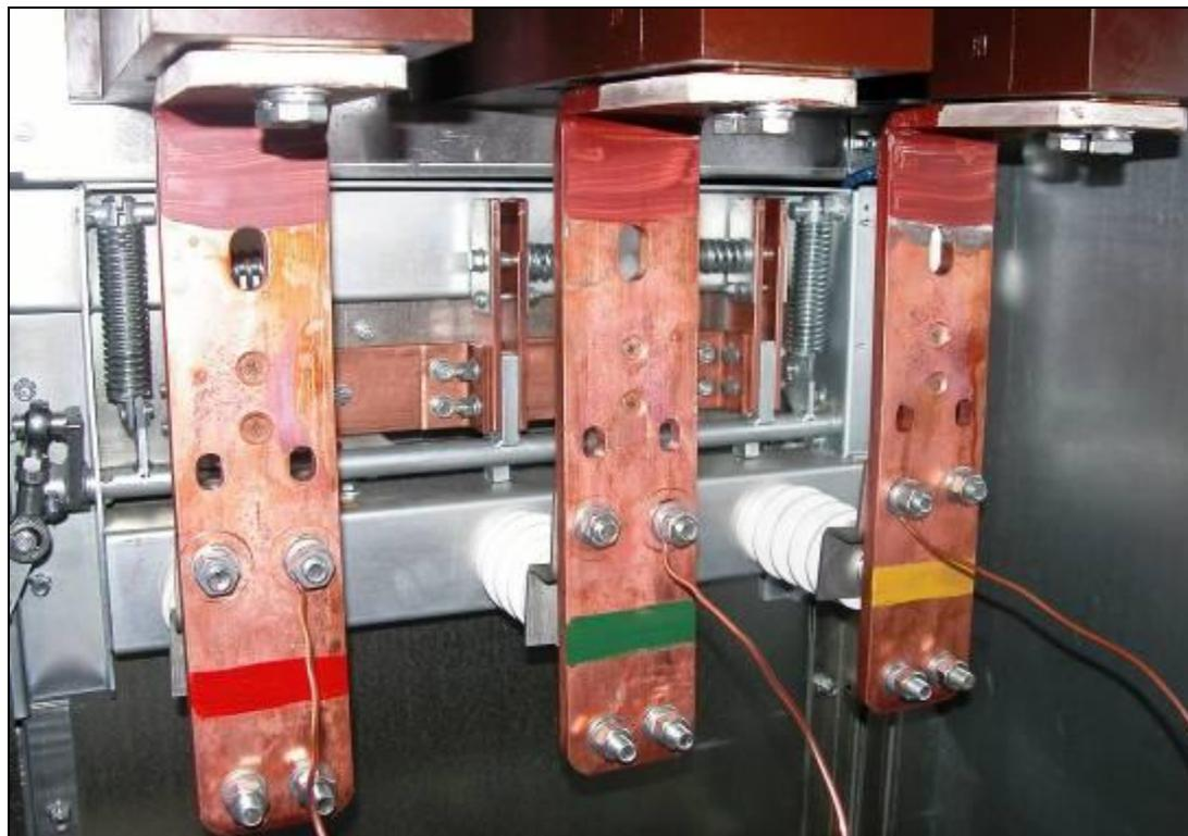
▲ Заземляющий разъединитель шкафа линии серии K-129.
