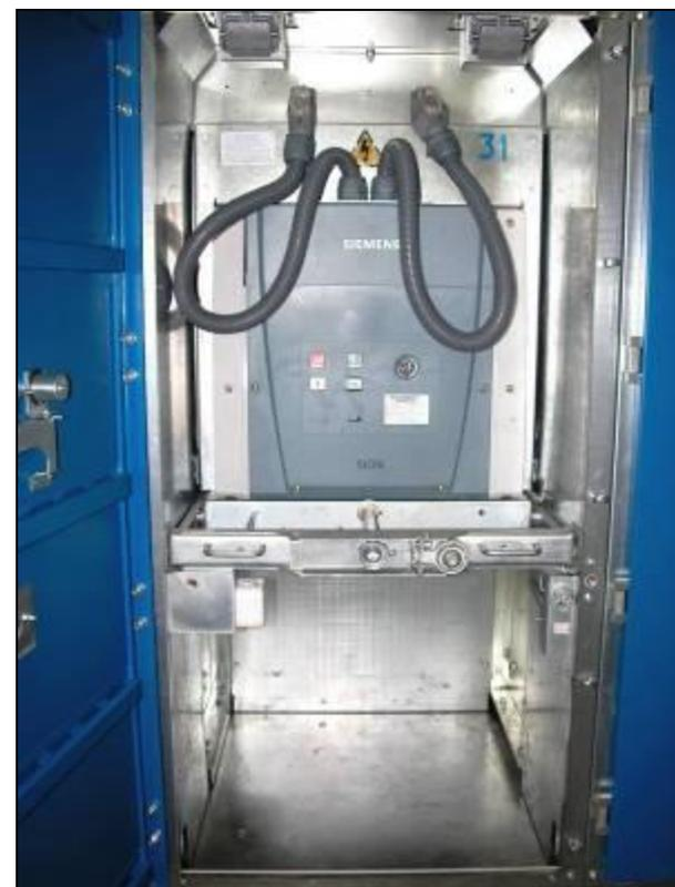
Отсек выключателя шкафа серии K-129 ►
