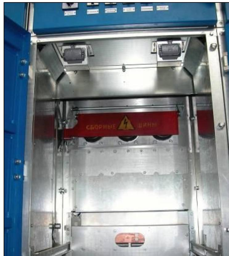
▲ Высоковольтный отсек для ТН шкафа серии K-129
