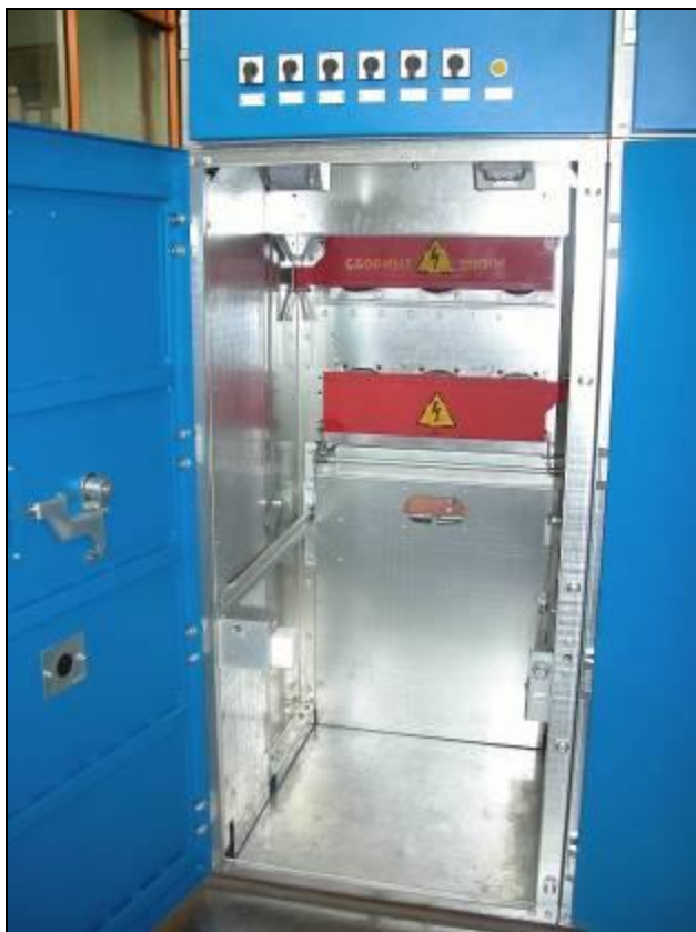
▲ Отсек выкатного элемента линейного шкафа серии K-129
