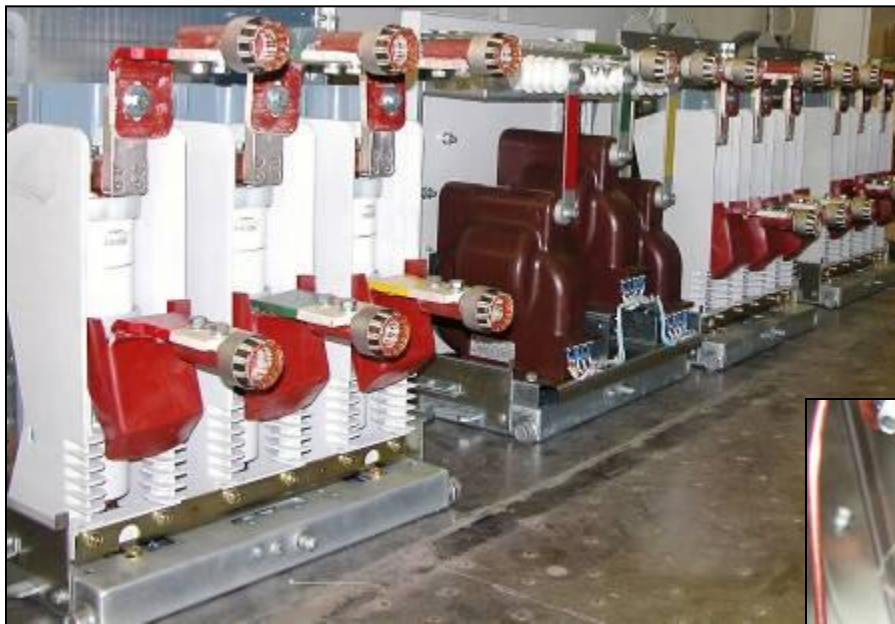
▲ Высоковольтные выключатели на выдвижных элементах.
