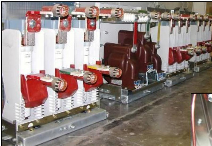
▲ Высоковольтные выключатели на выдвижных элементах.
