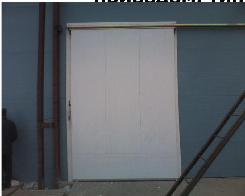
дверное полотно, наружная и внутренняя обшивка полотна из стального оцинкованного стального листа толщиной 0,55 мм. Плимовый покрытие. Направляющая планка установлена в нижней части дверного полотна
