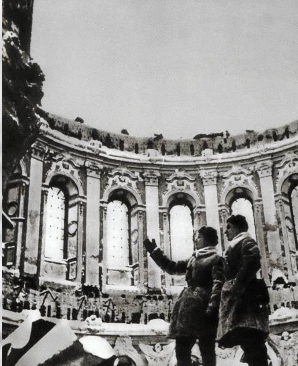
Разрушенный Воскресенский собор в Истре
