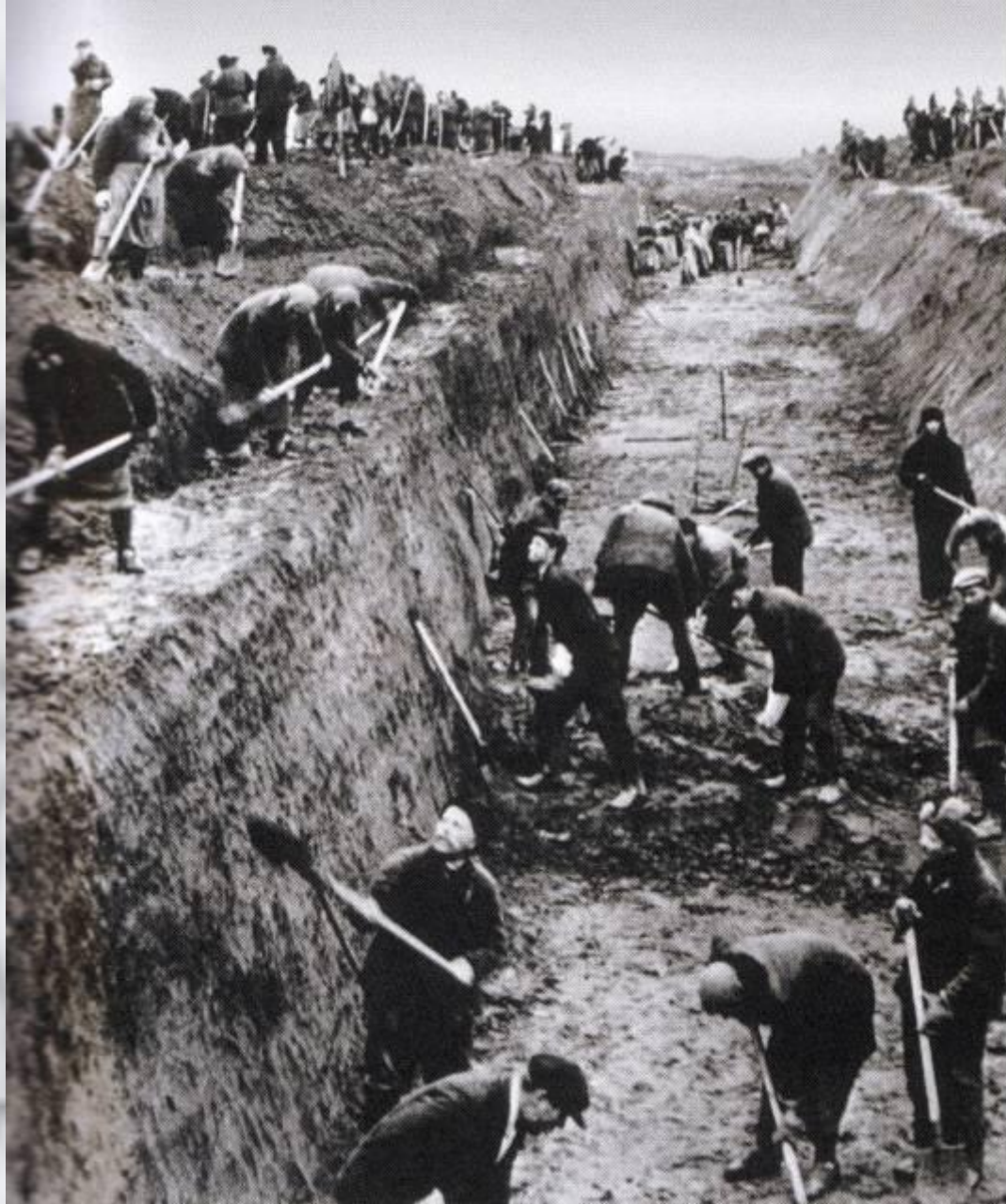
Москвичи на строительстве оборонительных рубежей
