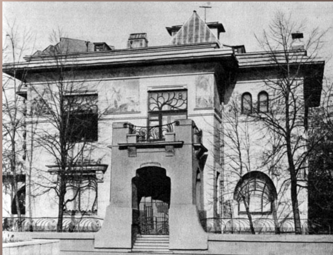
Бывший дом Рябушинского (архитектор Ф.О.Шехтель)
