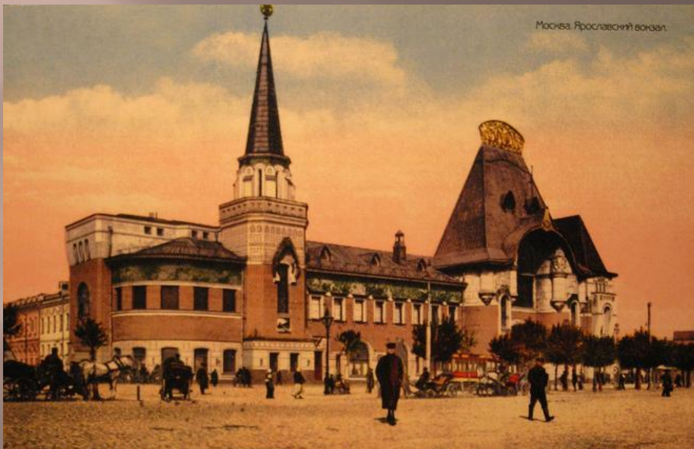
Ярославский вокзал (архитектор Ф.О.Шехтель)
