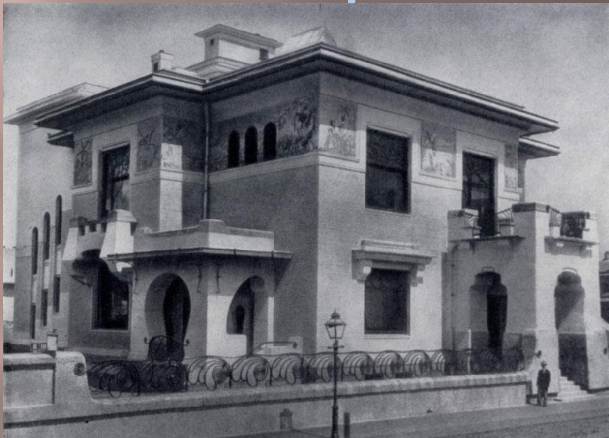
Бывший дом Рябушинского (архитектор Ф.О.Шехтель)
