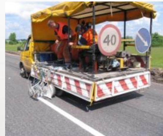
Прогрессивные машины и материалы для нанесения дорожной разметки
