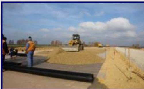
Использование геосинтетических материалов в слоях дорожных конструкций и в земляном полотне
