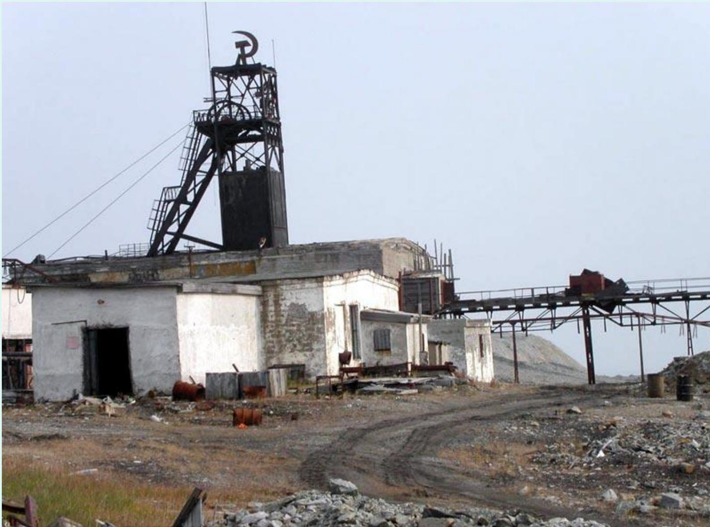
**Шахта – предприятие по добыче полезного ископаемого При помощи подземных горных выработок. Включает наземные сооружения и горные выработки.**
