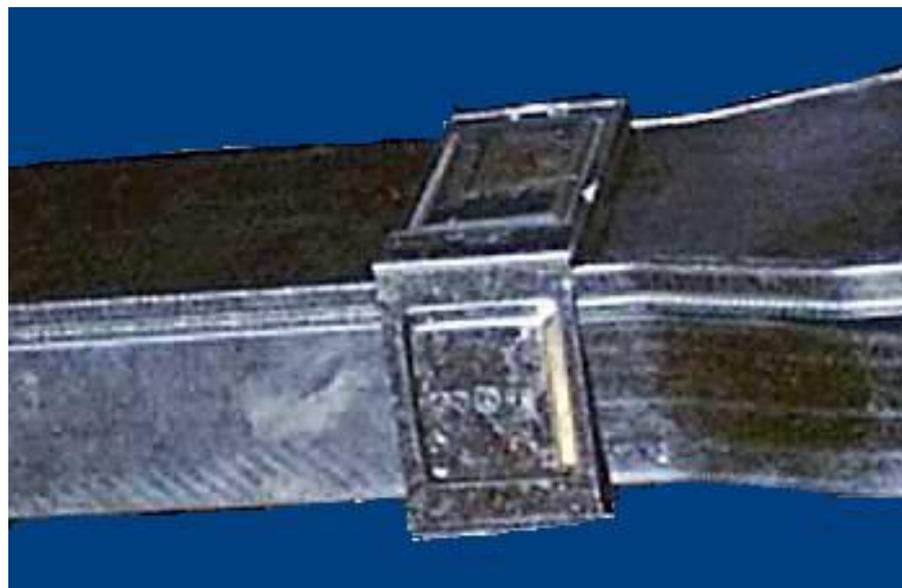
Использование специальных комплектов резино-пластиковых и металлических пластин на стыках обеспечивает защиту лотков от попадания влаги (IP44)
