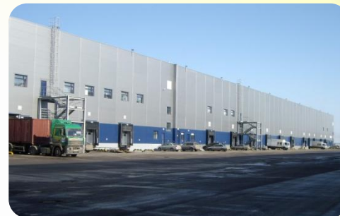
Складской комплекс «Крекшино»
