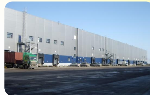
Складской комплекс «Крекшино»
