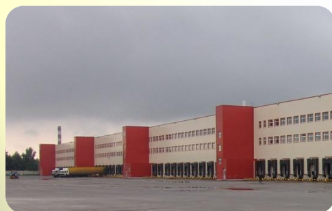
Склад высокого складирования «Химки»
