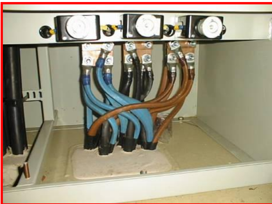
Силовое соединение, распределительный блок
