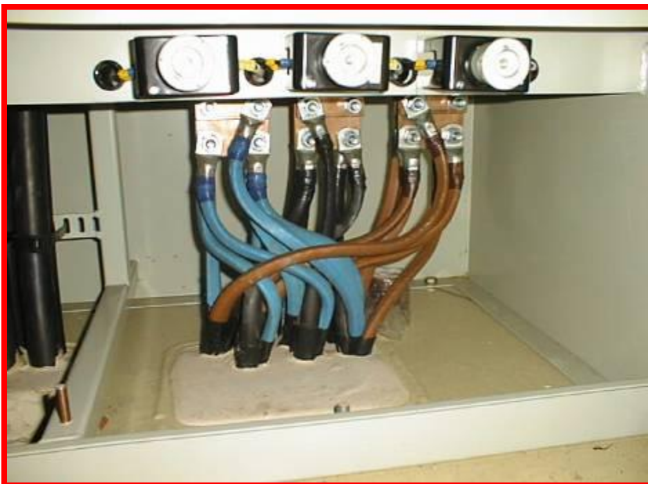
Силовое соединение, распределительный блок
