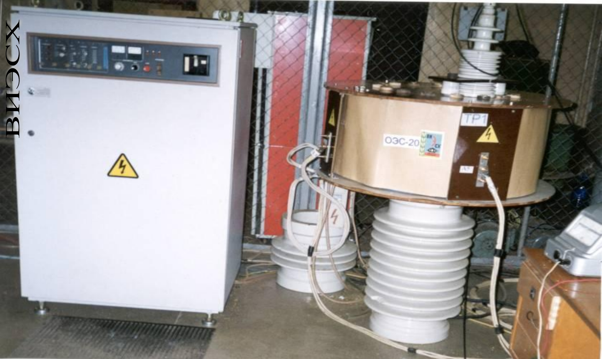
Преобразователь частоты и резонансный контур передающего высокочастотного трансформатора
