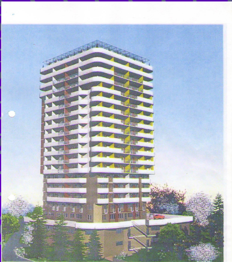
Многоквартирный жилой дом по ул. Параллельной в Центральном районе г. Сочи
