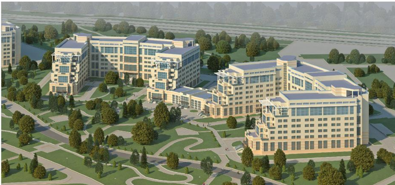
Тип II. Корпуса 6-8. Общий вид
