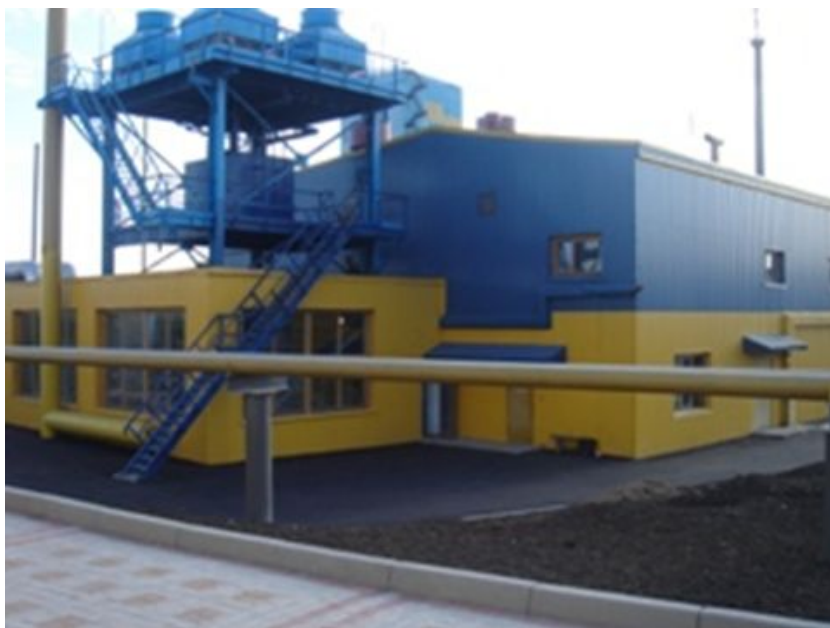
Рис.1. Вакуум-насосная станция (ВНС). Общий вид.
