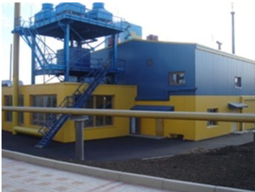
Рис.1. Вакуум-насосная станция (ВНС). Общий вид.
