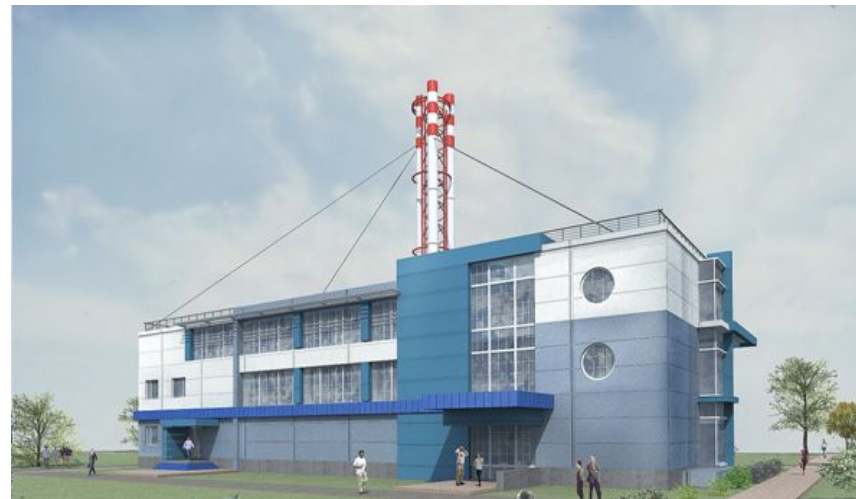
Ляпинская котельная после завершения проекта
