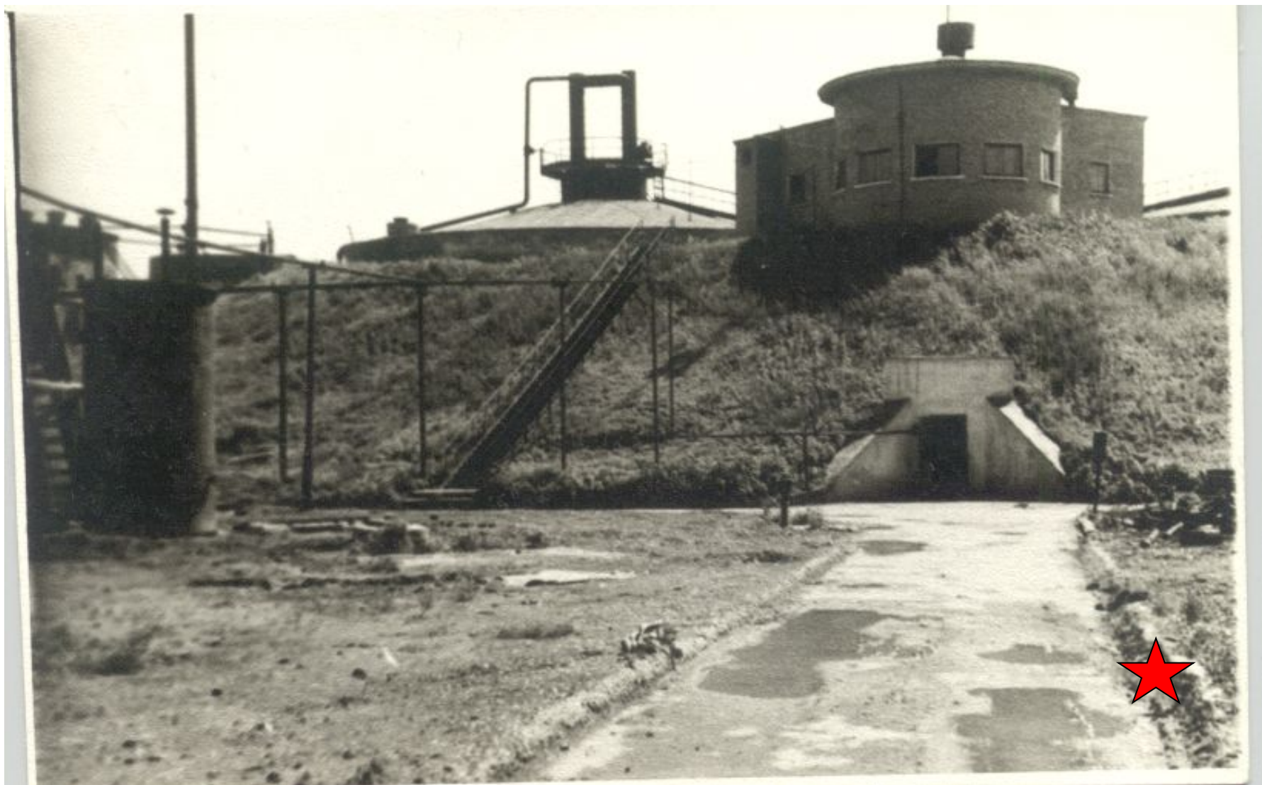
МЕТАНТЕНК ОБЪЕМОМ 4500 куб. м .Цех Витамин В-12 на Грозненском Ацетоно-бутиловом заводе 1970 г.
