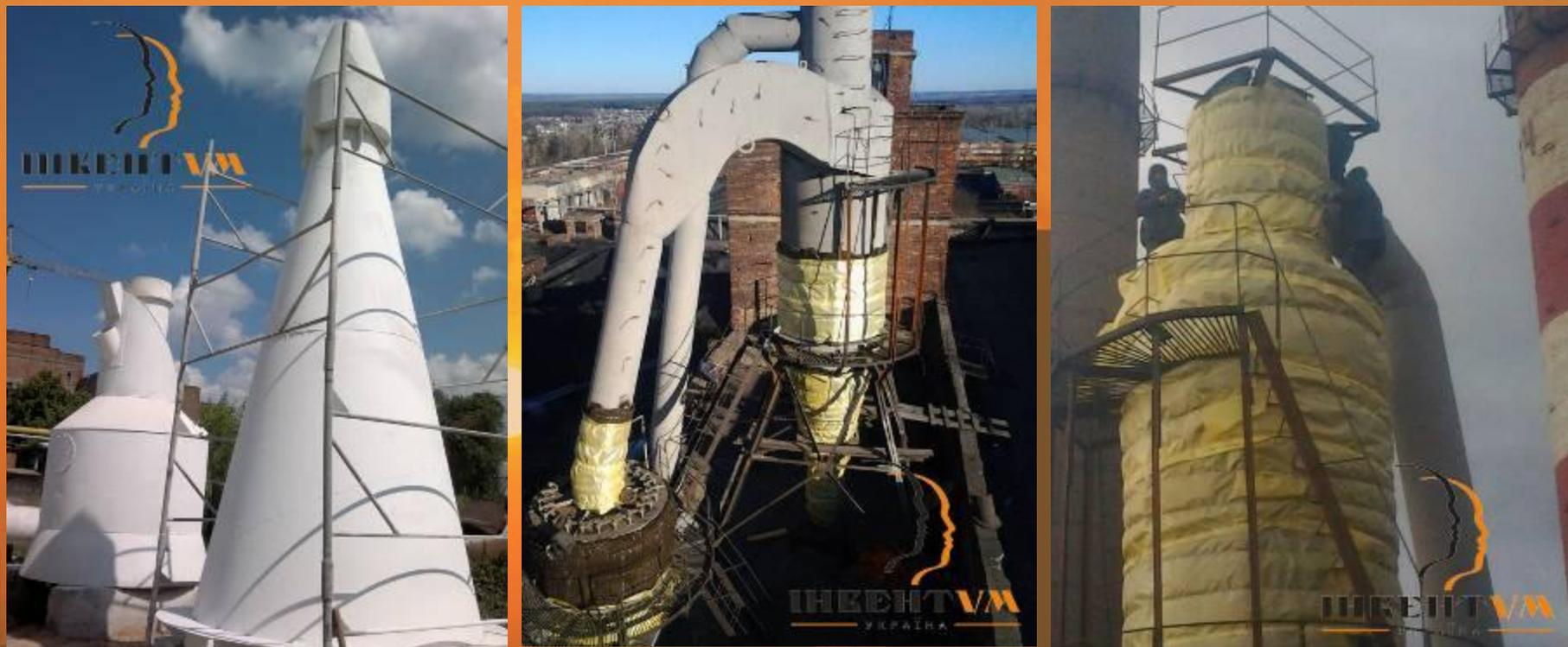
Техническим отделом компании было принято решение о применении комбинированного метода изоляции. В качестве первого изоляционного слоя была применена жидкая теплоизоляция "ТСМ Керамический". Дополнительной задачей материала "ТСМ Керамический" была антикоррозионная защита металлических частей циклонов и сепараторов пыли. Вторым теплоизоляционным слоем были выбраны базальтовые маты. В качестве защитного материала использована стеклоткань.
