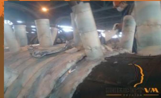
В течении октября - ноября 2011 года сотрудниками компании были выполнены работы по тепловой изоляции барабана парового котла на Луганской ТЭС. В качестве основного теплоизоляционного материала были использованы маты на основе керамического волокна LYTX-212. В качестве защитного (покрывного) слоя использовался рулонный стеклопластик.
