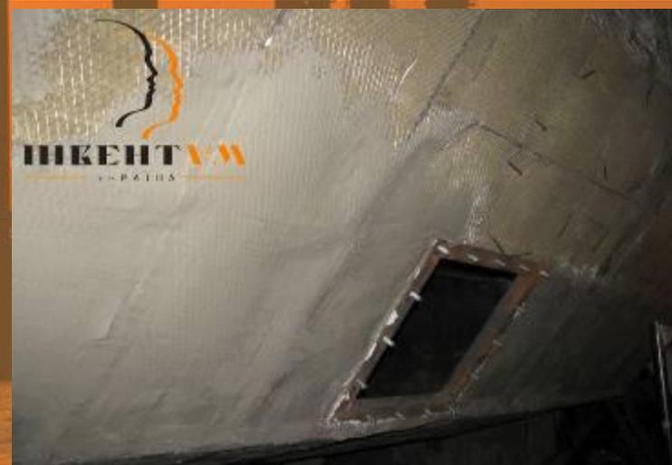
В октябре 2010 года сотрудники компании выполнили работы по тепловой изоляции контура котла на Дарницкой ТЭЦ. Основным теплоизоляционным материалом выбранным заказчиком стали плиты из базальтового волокна.
