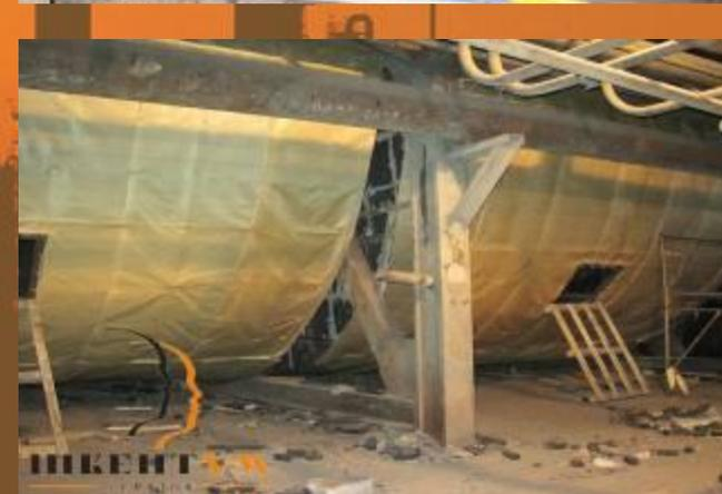
Сотрудниками компании в июле 2010 года были выполнены работы по тепловой изоляции контура котла на Дарницкой ТЭЦ. Одним из условий эксплуатации являлась возможность периодической помывки наружной поверхности без повреждения изоляции. С этой целью применены плиты из пеностекла.
