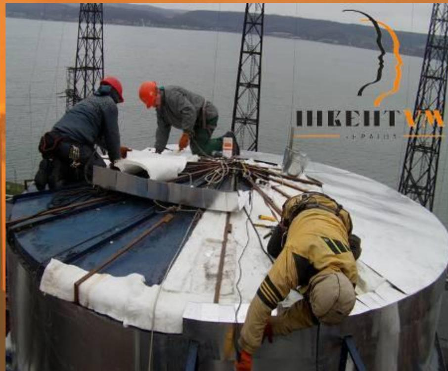
С марта по август 2011 года сотрудники компании выполнили работы по изоляции корпуса электрофильтра и батарейных циклофильтров пылеулавливателей блока №7 на Бурштынской ТЭС общей площадью 1400 м<sup>2</sup>. В качестве основного изоляционного материала циклофильтров заказчик выбрал маты на основе керамического волокна LYTX-212, в качестве защитного слоя - алюминиевый лист.
