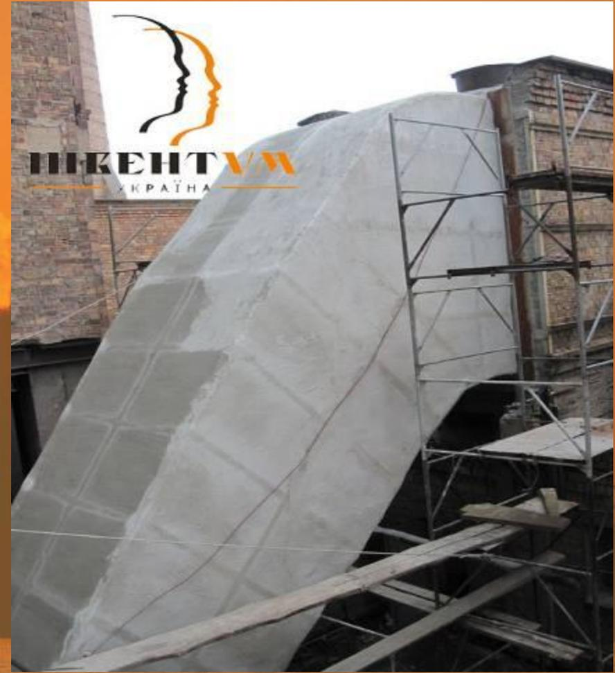
Сотрудники компании в августе 2010 года выполнили теплоизоляционные работы на Дарницкой ТЭЦ. Основным теплоизоляционным материалом выбранным заказчиком для изоляции газоходов стали плиты из базальтового волокна.
