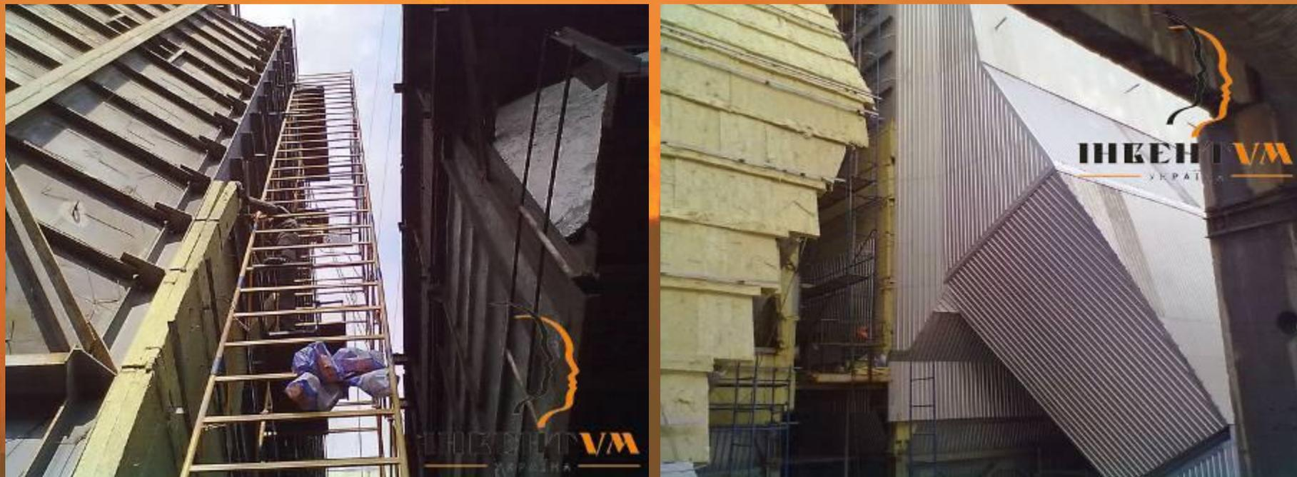
С марта по август 2011 года сотрудники компании выполнили работы по изоляции корпуса электрофилтра блока №7 на Бурштынской ТЭС общей площадью 2000 м<sup>2</sup>. В качестве изоляционного материала корпуса электрофилтра заказчик выбрал плиты на основе базальтового волокна, в качестве защитного слоя - профнастил.
