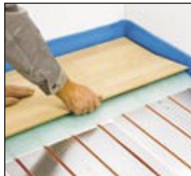
Укладка деревянного пола
