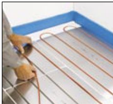
Укладка греющего кабеля
