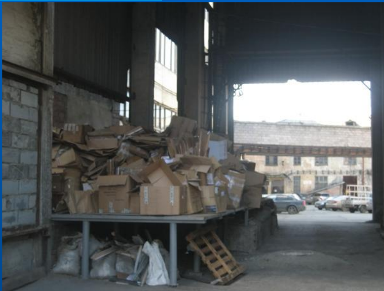
Дебаркадер с деревянным покрытием и навесом от дождя
