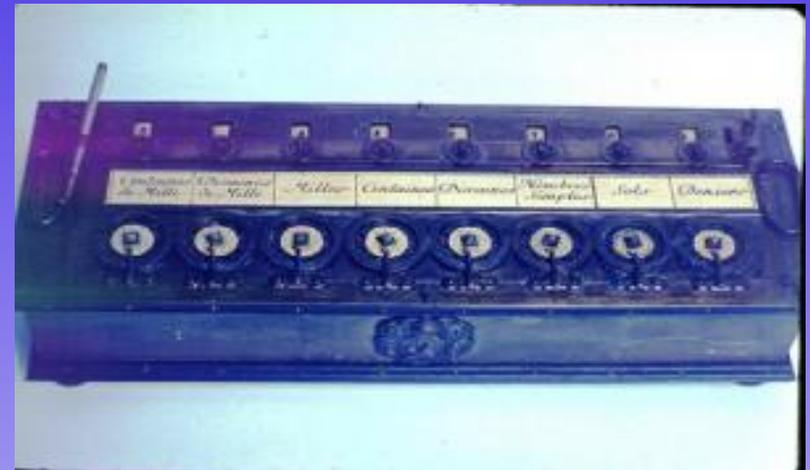
Она представляла собой легкий латунный ящик размером 350x125x75 мм. На верхней крышке 8 круглых отверстий, вокруг каждого нанесена круговая шкала. Шкала крайнего правого отверстия разделена на 12 равных частей, шкала соседнего с ним отверстия — на 20 частей, шкалы остальных 6 отверстий имеют десятичное деление. Такая градуировка соответствует делению ливра — основной денежной единицы того времени — на более мелкие: 1 су=1/20 ливра и 1 денье=1/12 су.
