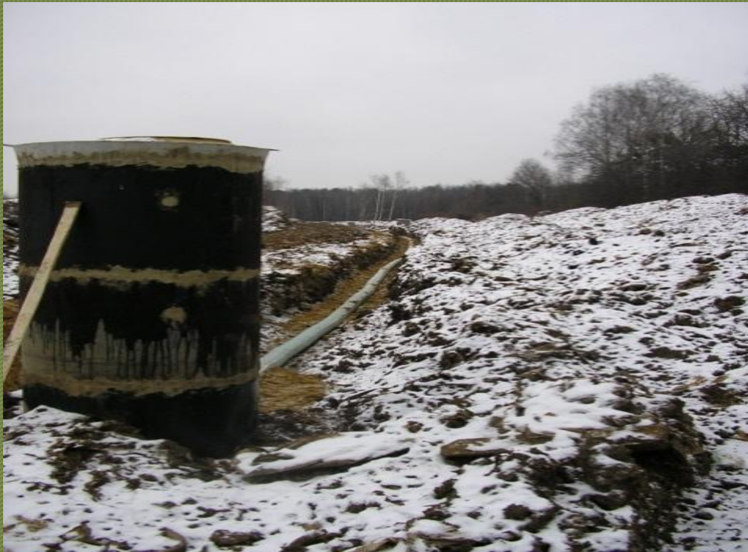
Строительство дренажной системы для сбора и удаления фильтрата
