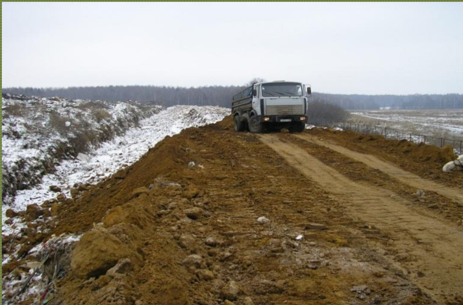
Устройство дамбы обвалования
