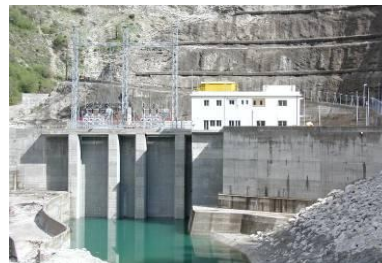
ГЭС МЕЗОХОРА 2 X 90 МВА ГРЕЦИЯ
