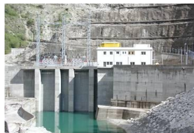
ГЭС МЕЗОХОРА 2 X 90 МВА ГРЕЦИЯ
