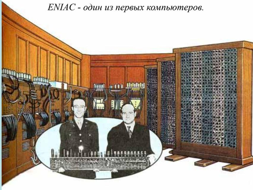
Одной из первых и самой известной электронно-вычислительной машиной стал компьютер ENIAC (Electronic Numerical Integrator Analyzer and Computer). Он был создан в Пельсенвальском университете Проспером Экертом и Джоном Мокли для нужд американской армии в 1945 г. Эта первая ЭВМ имела почти 20 тыс. ламп и занимала 74 кв.м.
