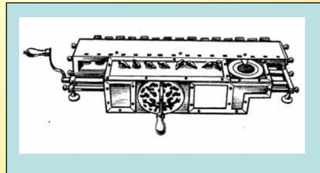
В первой половине XIX века англичанин **Чарльз Бэббидж** (1791-1871) разработал конструкцию машины, по многим причинам достойной называться первым компьютером. Но в те времена (Бэббидж начал свою работу в 1834 году) подобная машина могла быть только механической. Но точность изготавливаемых деталей, необходимая для этой машины, в середине XIX века была просто недостижима.
