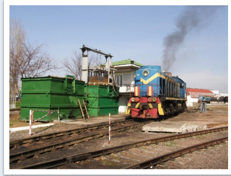
Установка реостатных испытаний.
