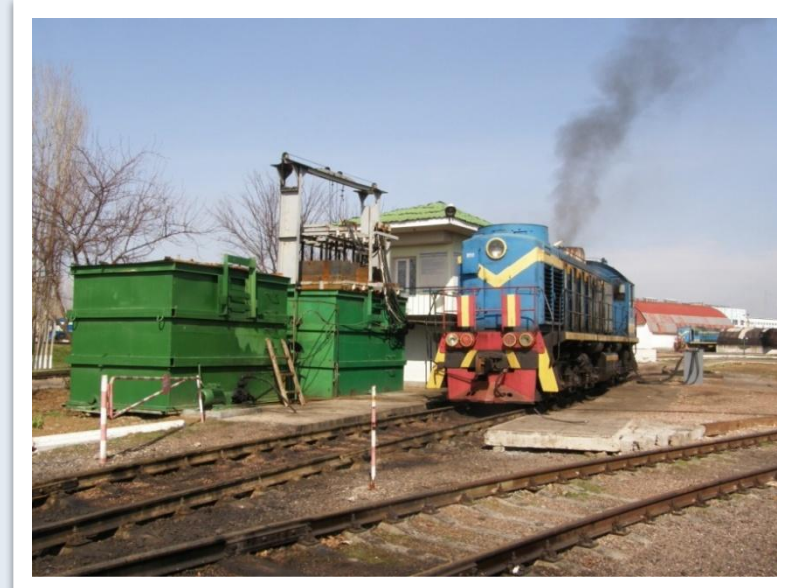
Установка реостатных испытаний.
