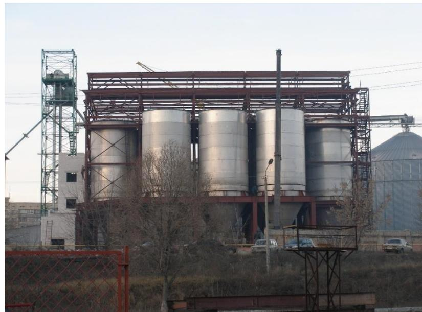
*20 емкостей из нержавеющей стали объемом по  $300\text{ м}^3$  каждая, и 12 емкостей объемом  $350\text{ м}^3$  из углеродистой стали*
