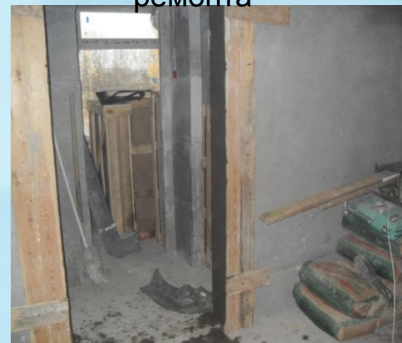
Реанимационное отделение (Няндомы) в процессе ремонта
