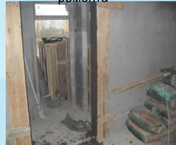
Реанимационное отделение (Няндомы) в процессе ремонта
