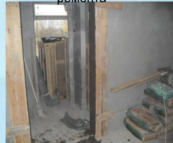
Реанимационное отделение (Няндомы) в процессе ремонта
