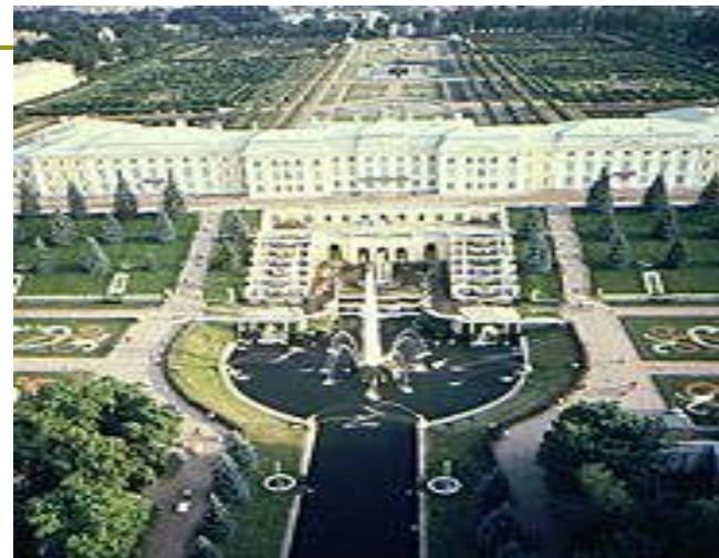
Большой дворец с водяным каскадом
