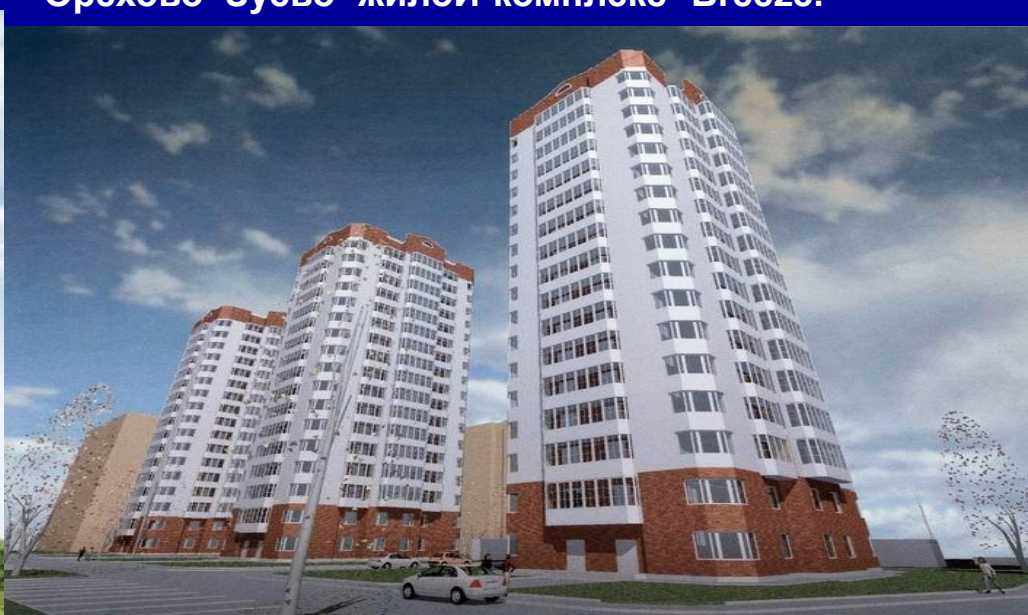
Жилой комплекс "Северное Трио."
