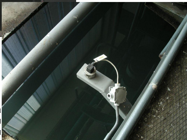
ULM-55 на станции ВОДОЧИСТКИ
