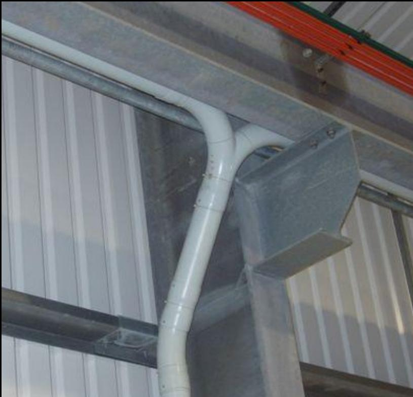
Вакуумные магистрали собираются из стальных труб, покрашенных порошковым методом. Особая конструкция изгибов позволяет доставлять пыль и воздух на большие расстояния.
