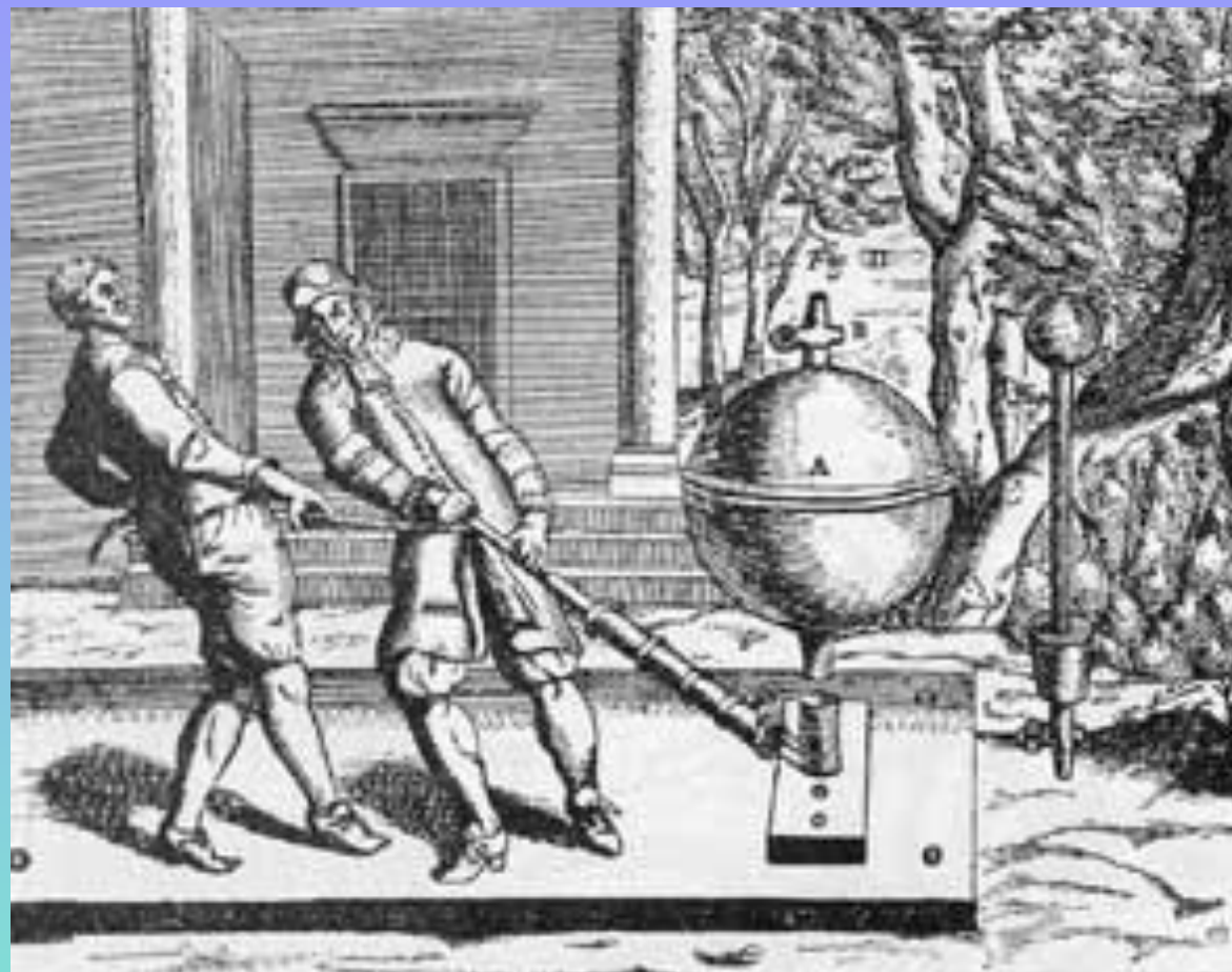
Рис. 4. Принцип устройства насоса Герике
