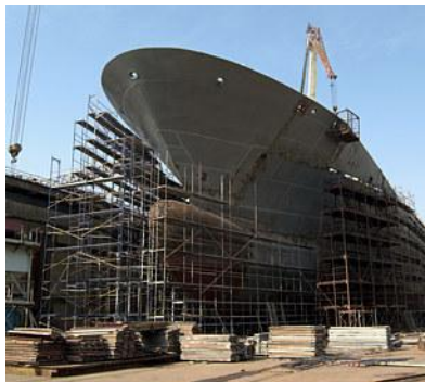
Кораблестроение и ремонт
