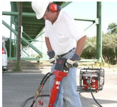
Строительство и добывающая промышленность
