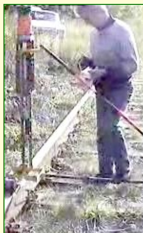
Костылезабивщик на базе двигателя мотоскореходов
