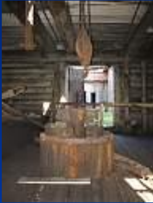
Скважина внутри рассолоподъемной башни
