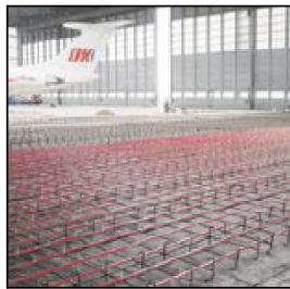
Темперирование ядра бетона
