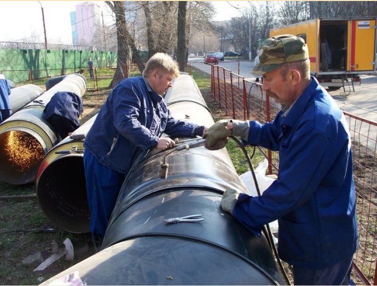
Изолировка внешней трубы
