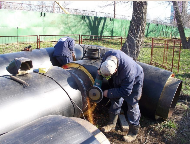
Сварка стальной трубы Д 700 мм
