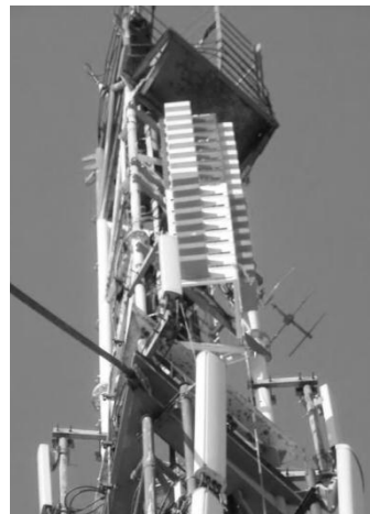
Замена аварийного оборудования
