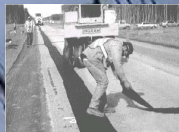
Дорожно-строительные работы: асфальтовое покрытие
