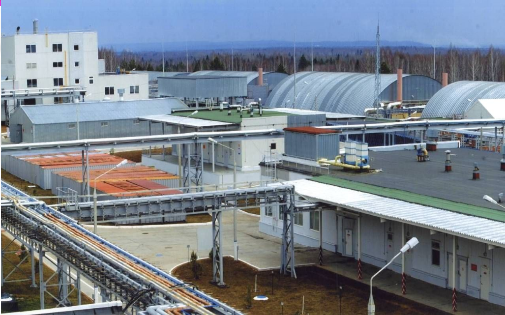
Общий вид промышленной зоны объекта
