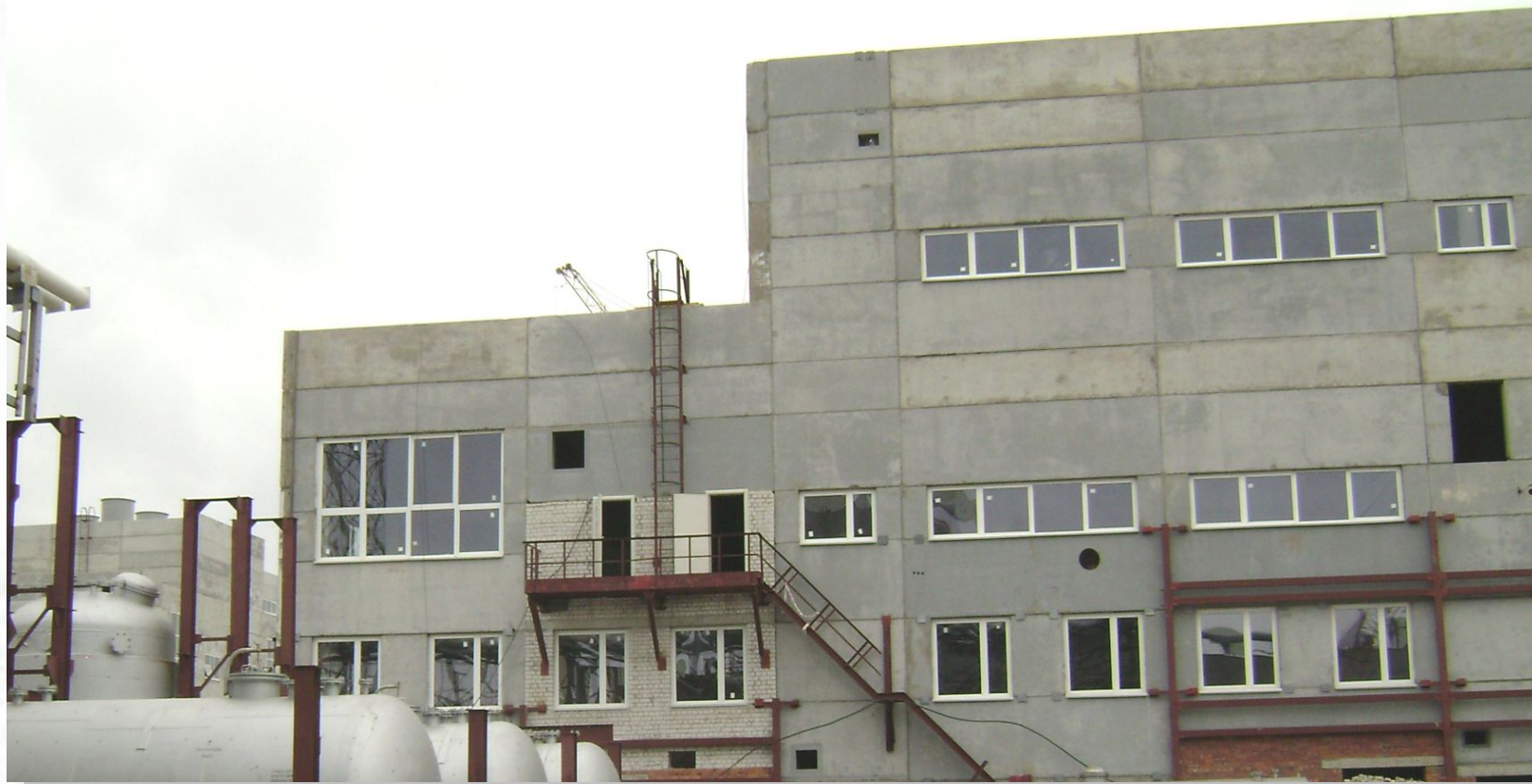
Общий вид производственного корпуса по уничтожению боеприпасов
