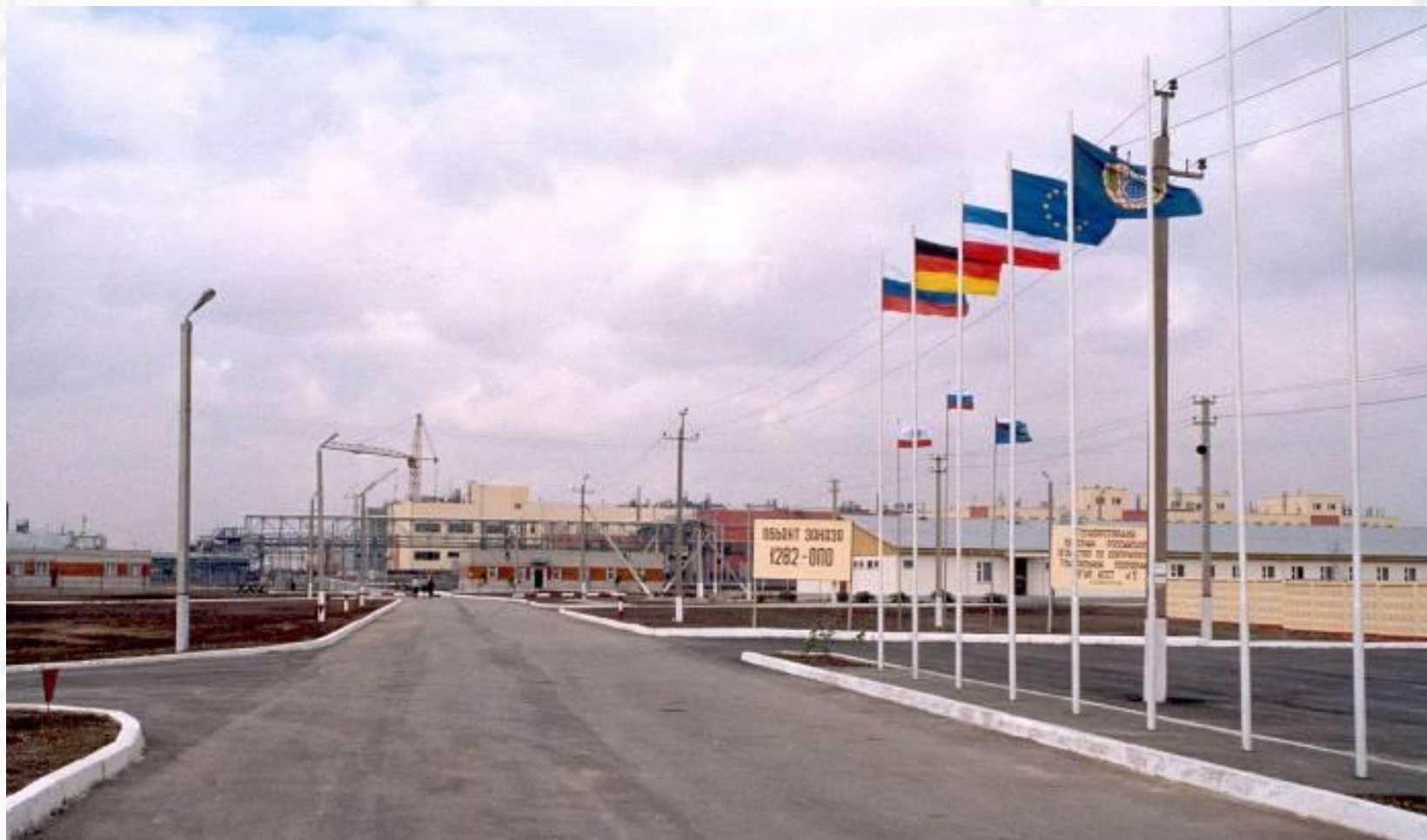
Общий вид промышленной зоны объекта
