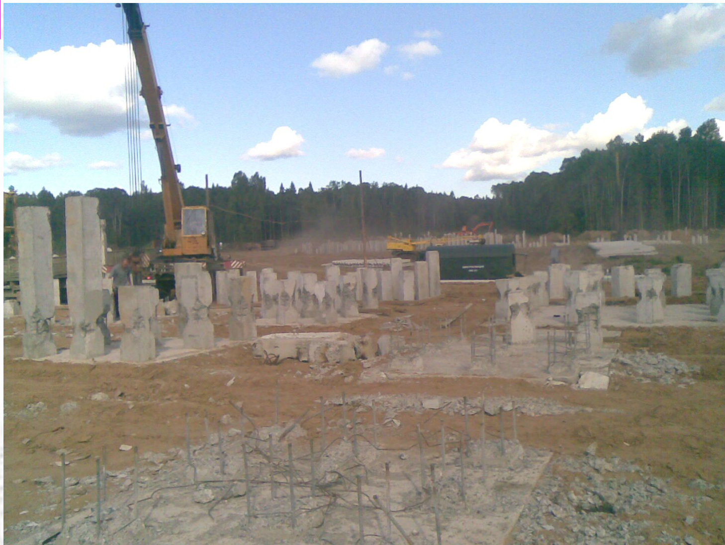
Забивка свайного поля для строительства зданий (сооружений) промышленной зоны объекта
