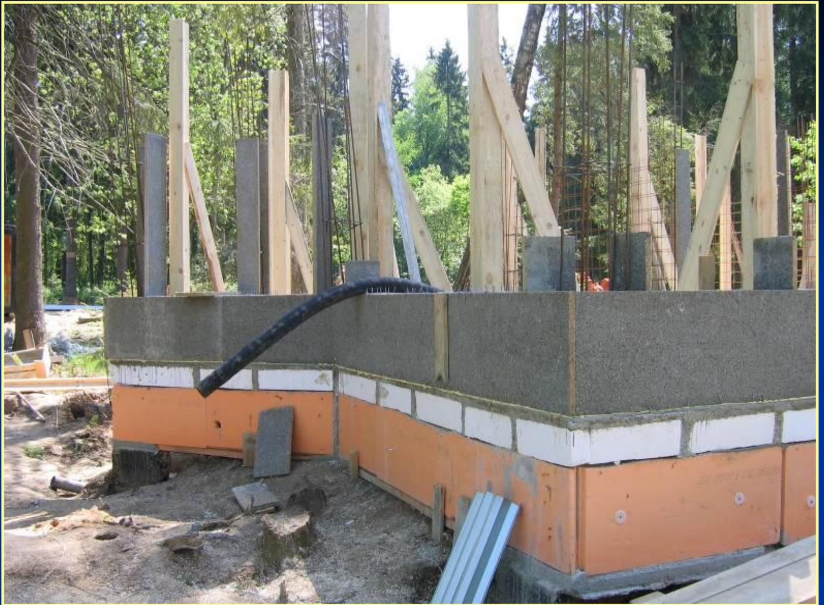
Столбчатый монолитный фундамент с монолитным железобетонным ростверком
