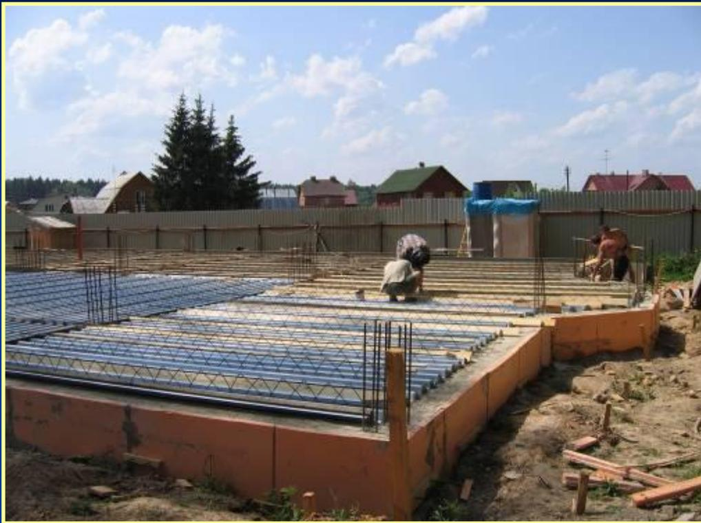
Монолитные перекрытия в конструкциях с несъемной опалубкой применяются двух типов:
