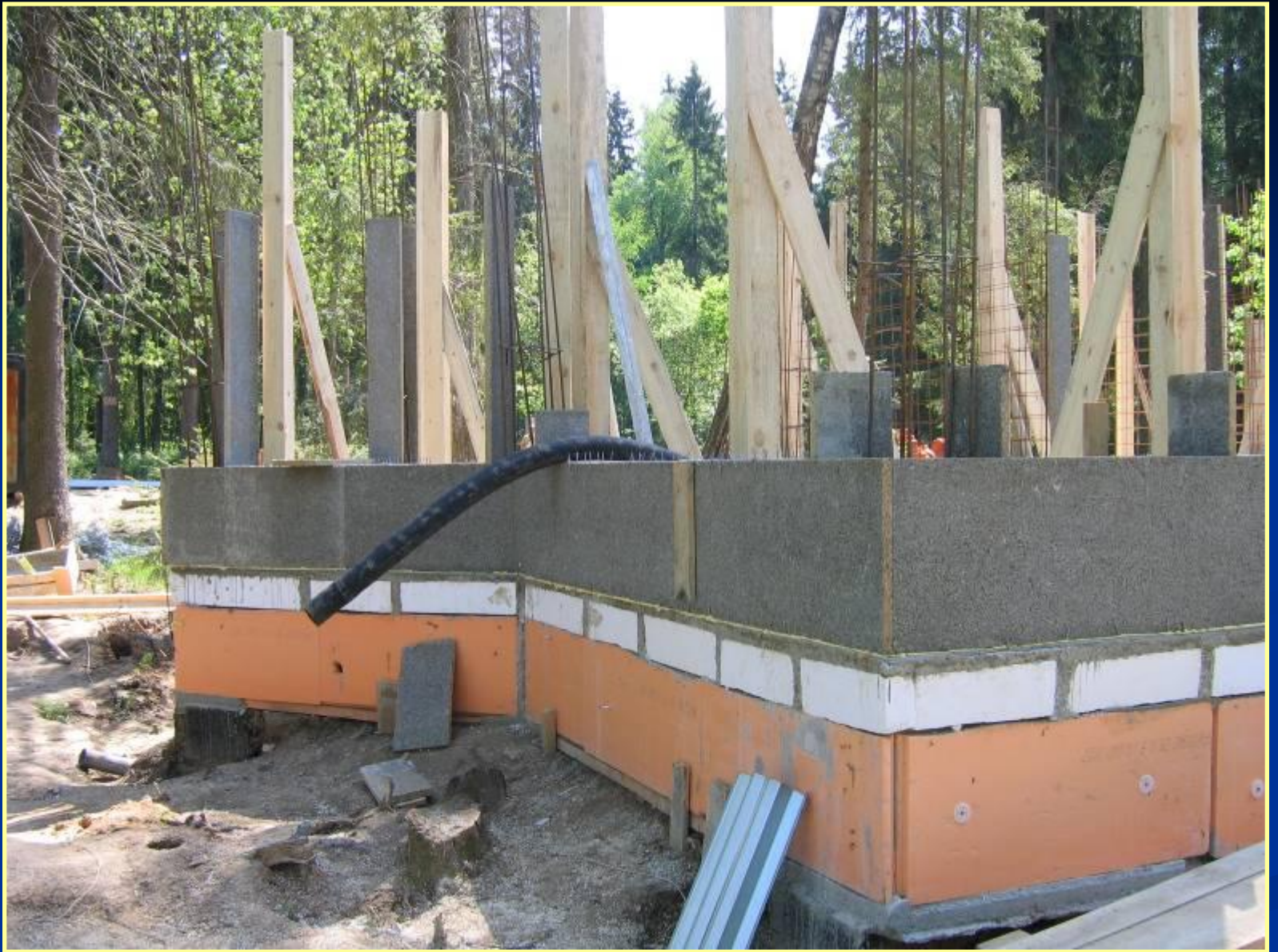
Столбчатый монолитный фундамент с монолитным железобетонным ростверком
