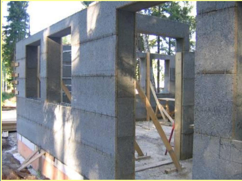
Сформированные из плит СЦП стены заливаются пенобетоном плотностью 600-800 кг/м<sup>3</sup>. Существует несколько типов конструкций стен. Если здание имеет высоту до 2 этажей, то достаточно армировать бетонное ядро арматурой с интервалом 0,6 м, а на углах и в проемах монтировать арматурные тригоны. Если здание выше двух этажей, то в теле стены формируются колонны из тяжелого железобетона.
