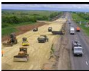
1. Строительство и ремонт дорог
