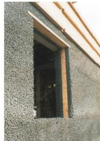
Омоноличенная стена с оконными проемами
