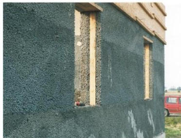
Омоноличенная стена с оконными проемами
