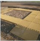
В 2009г. освоен выпуск новой продукции – Плиты бетонные тротуарные с тактильной поверхностью ТПТ50,50,10, применяемые в качестве наземных указателей для инвалидов по зрению в соответствии с ГОСТ Р52875-2007. В настоящее время завод выпускает плиты 3-х модификаций: «Прямо», «Диагональ» и «Опасность»
