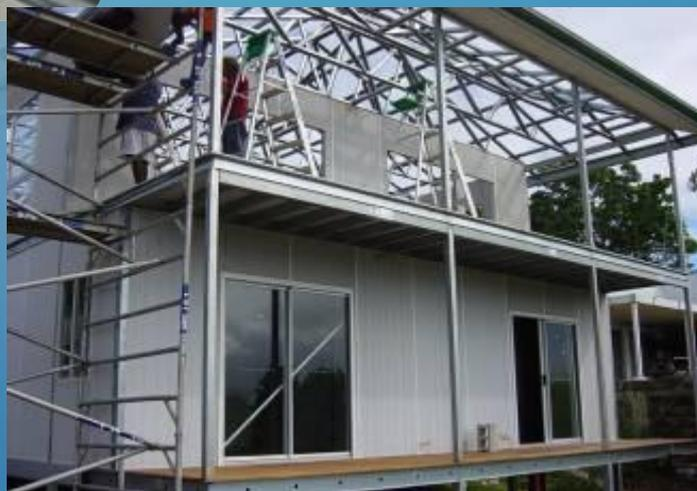
Установка в три этажа без дополнительной рамы
