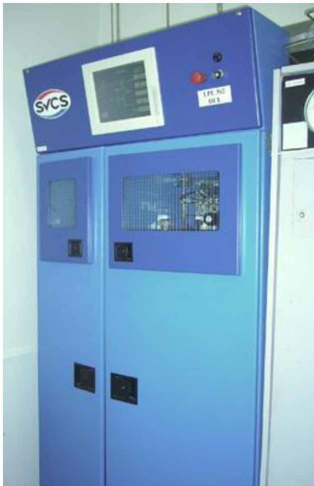
Автоматический шкаф для HCl
