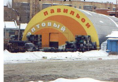
Павильон Екатеринбург (50 кВт)
