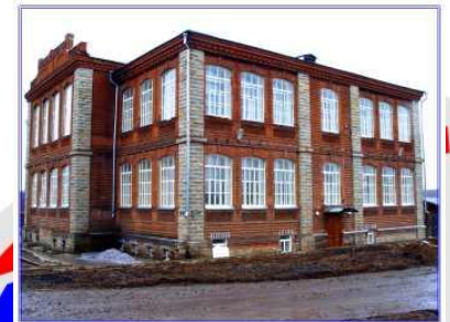
Школа Г. Верхотурье (289 КВт)
